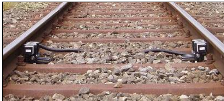
Magnetfeldmessung (TS 50238-3, Netzzugang)
