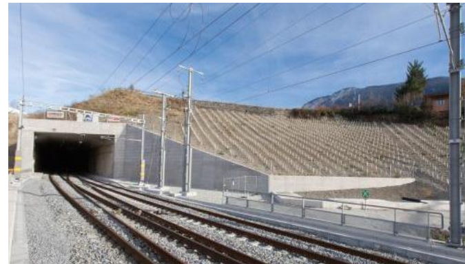
Tunnel de Gobet, Sierre
