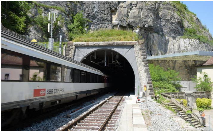
Tunnel de St-Maurice
