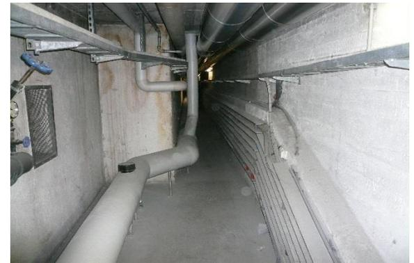
Medienkanal mit Asbest zwischen E15 und E43
