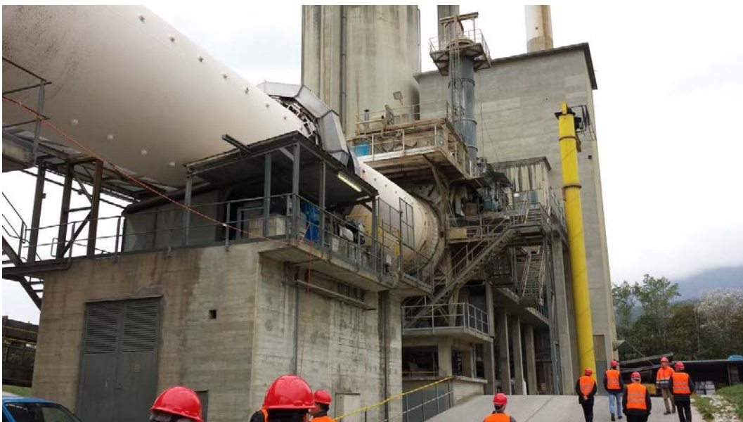
Partie supérieure du four rotatif de la fabrique de ciment à Cornaux.
