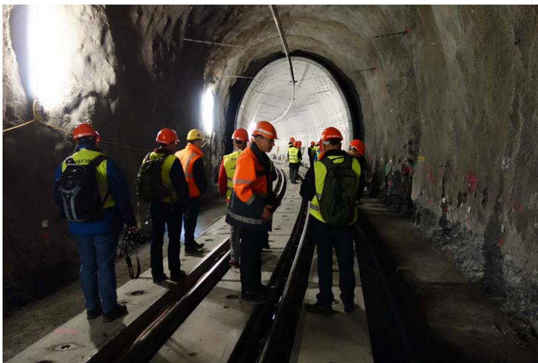
Remise à neuf de l'habillement du tunnel du Glatscheras par des éléments en béton préfabriqués (Photo: Martin Strobel).
