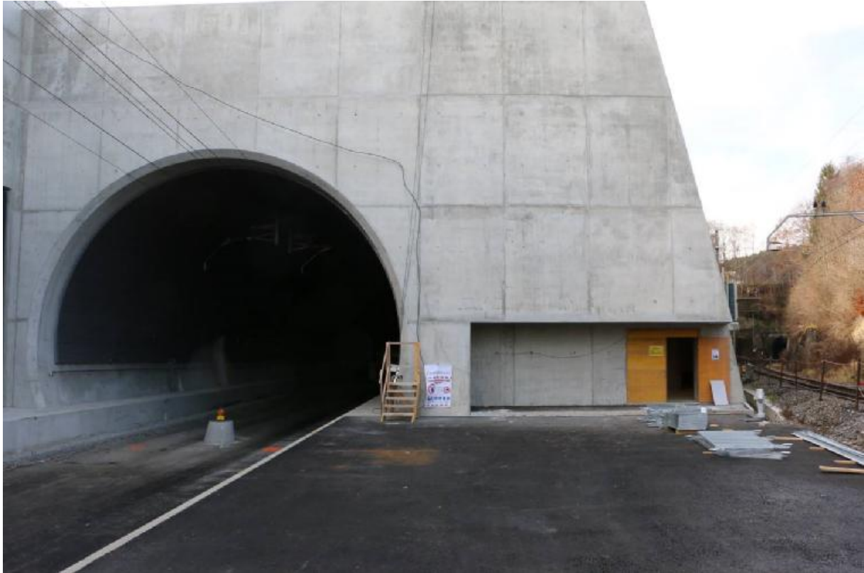
Ostportale des neuen und alten Rosshäuserntunnel.
