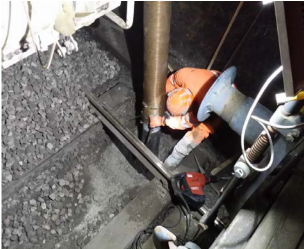
Freilegen der Betonsohle
