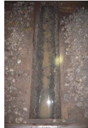
Durchnässtes / verschmutztes Schotterbett
