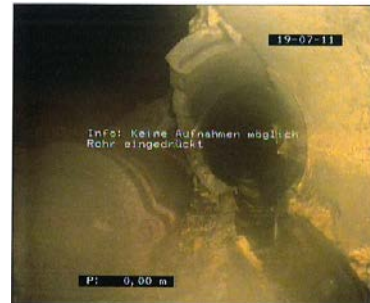
Foto: 29_2a, Videoband Nr.: DVD, 00:00:00 0m, Info: Keine Aufnahmen möglich Rohr eingedrückt
