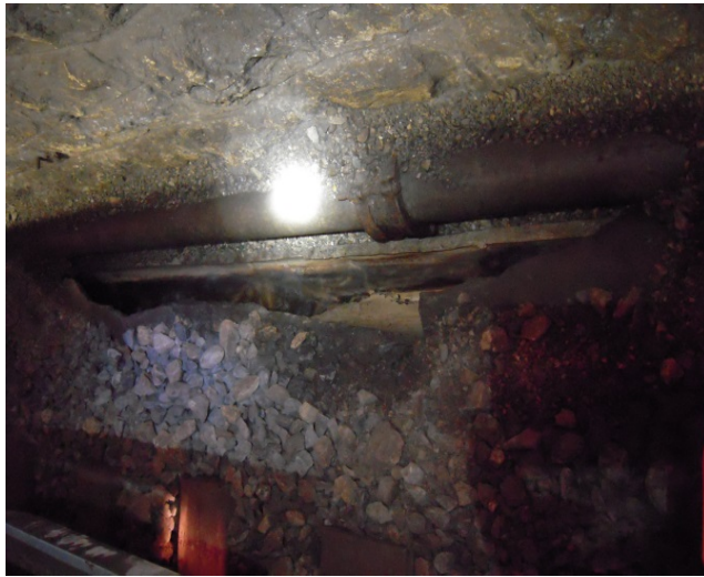
Eingebrochene Seitenentwässerung
