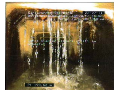
Foto: 23_25a, Videoband Nr.: DVD, 00:28:01 193.62m, Info: Starker Wassereintritt im Scheitel
