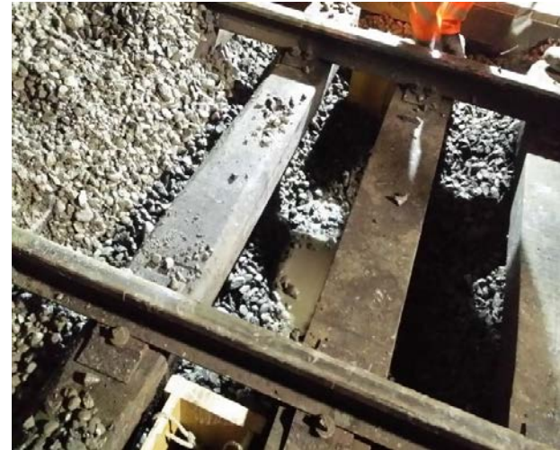
Freigelegte Sohle mit hohem Wasserstand
