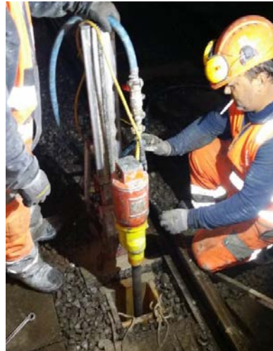
Kernbohrung
