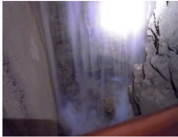
Wasserquelle am Parament
