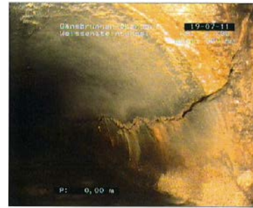
Foto: 2_3b, Videoband Nr.: DVD, 00:00:14 0m, Scherbenbildung, ges. Umfang, 2 mm, Schadensanfang
