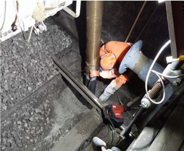
Dégagement du radier en béton
