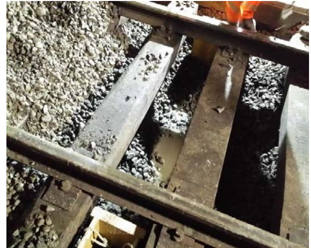
Radier dégagé avec niveau d'eau élevé
