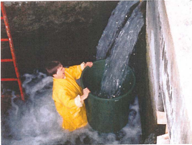
Évacuation au niveau du portail d'Oberdorf
