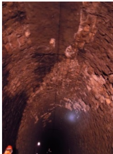
Formation de pression au niveau des jonctions sur une grande surface
