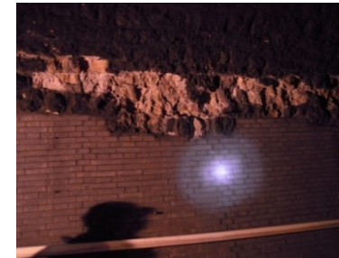
Éclats suite à la formation de pression au niveau des jonctions
