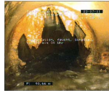
Foto: 25_9a, Videoband Nr.: DVD, 00:08:40 40.66m, Inkrustation, feucht, Scheitel, von 08 bis 04 Uhr
