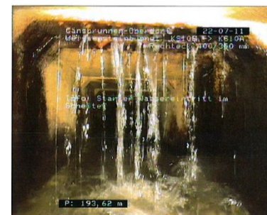
Foto: 23_26a, Videoband Nr.: DVD, 00:28:01 193.62m, Info: Starker Wassereintritt im Scheitel
