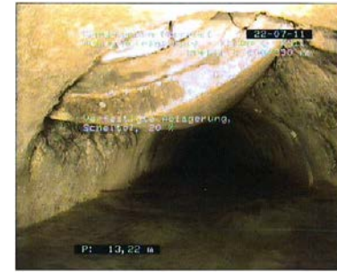
Foto: 22_5a, Videoband Nr.: DVD, 00:05:06 13.22m, Verfestigte Ablagerung, Scheitel, 20 %
