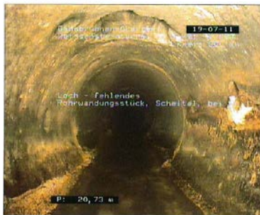
Foto: 1_9a, Videoband Nr.: DVD, 00:07:41 20.73m, Loch - fehlendes Rohrwandungsstück, Scheitel, bei 12 Uhr
