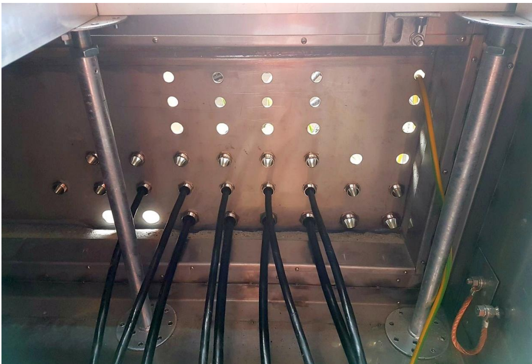
Abb. 57: Einführungsplatte Ansicht im Gebäudeinneren
