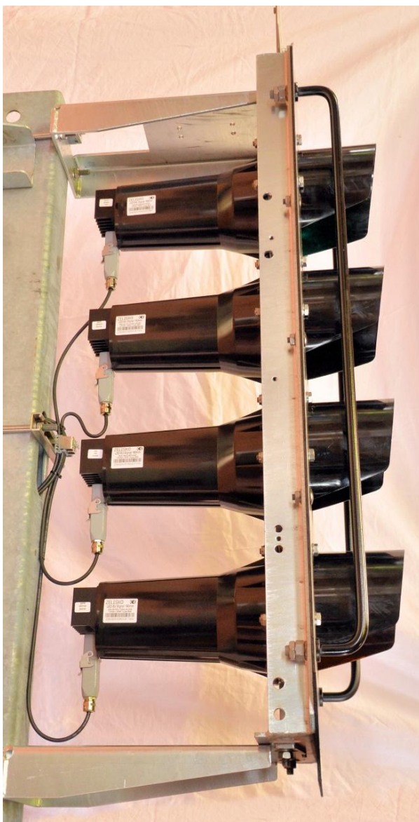
Abb. 63: links: ZELISKO-Lampeneinsätze, Beispiel montiert an einem Hauptsignal
