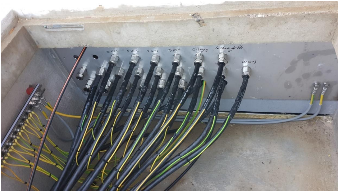
Abb. 56: Einführungsplatte Ansicht im Kabelschacht
