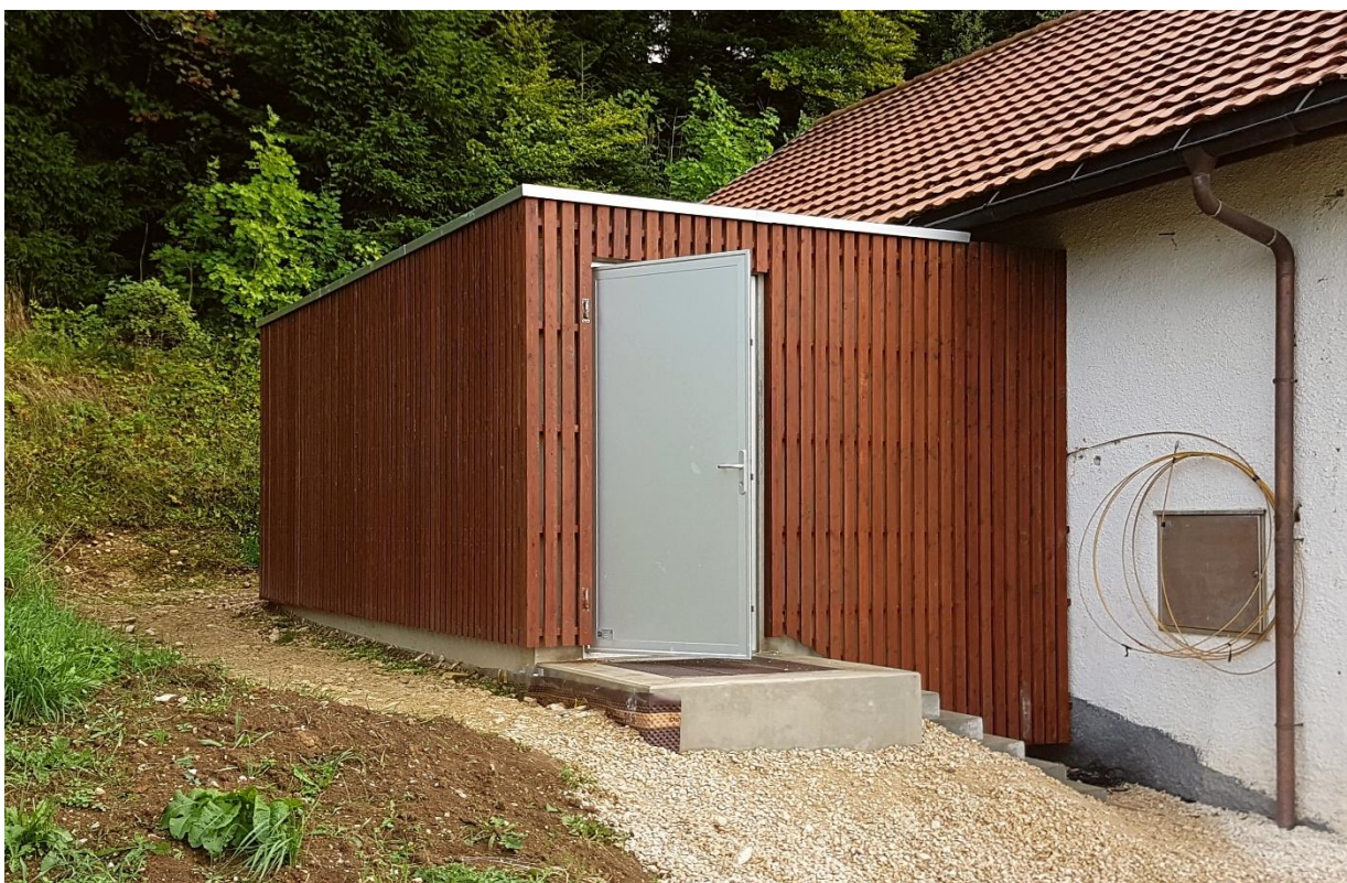
Fig. 47: Extérieur du bâtiment UF 3066 avec revêtement en bois
