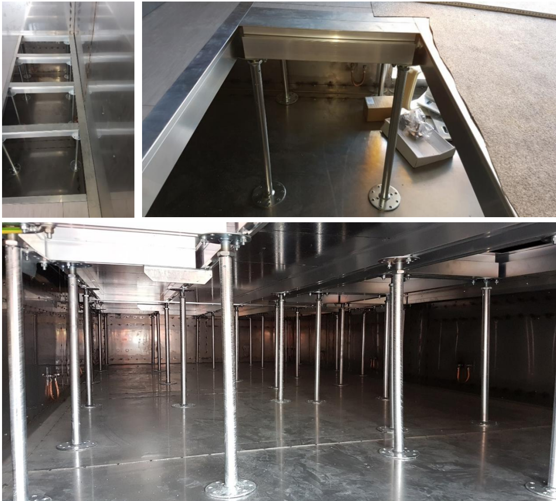
Fig. 55: Intérieur du bâtiment : revêtement en acier fin, sol creux vu d'en haut et d'en bas
