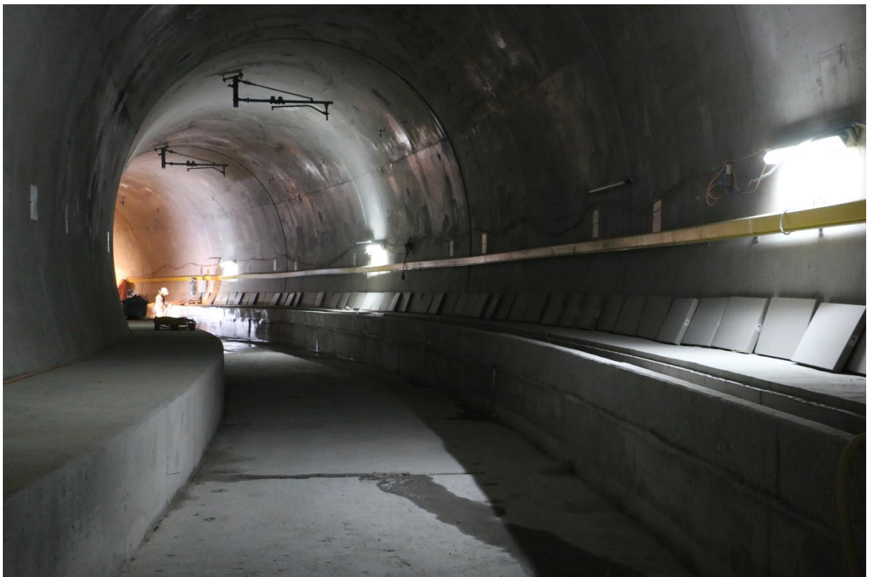
Tunnel de Riethüsli en état brut.
