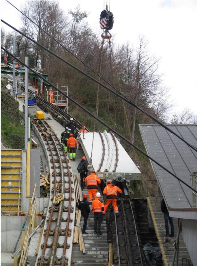
Gleiswender in Grube versetzen:
