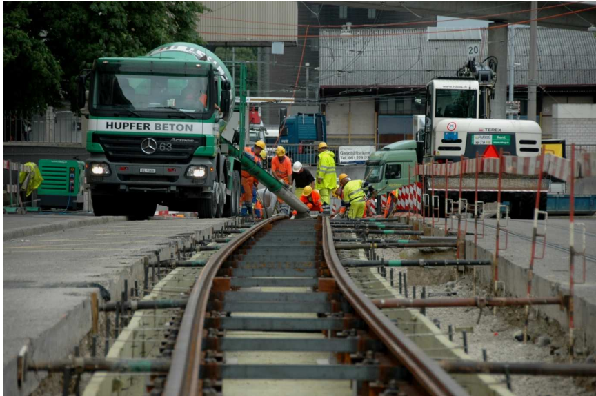
Chantier de voie Zeughausstrasse (Photo M. Bossard).
