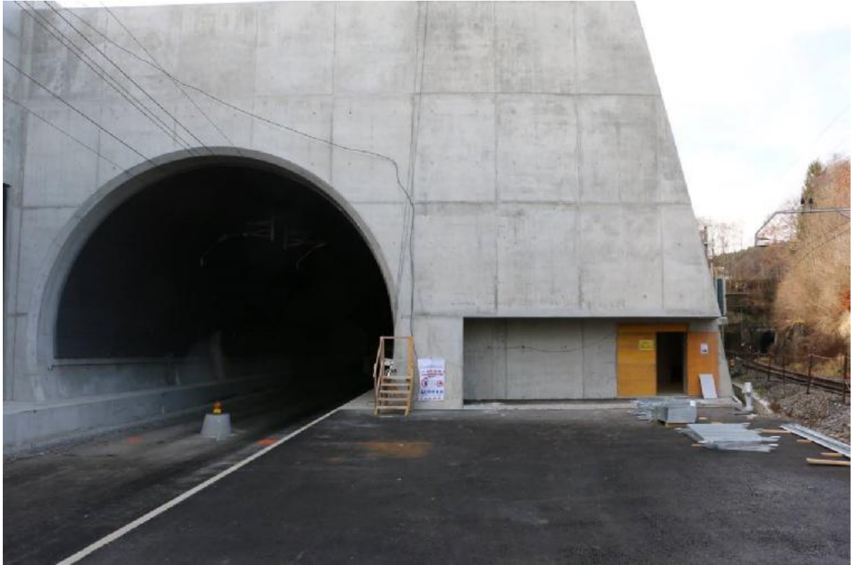
Ostportale des neuen und alten Rosshäuserntunnel.
