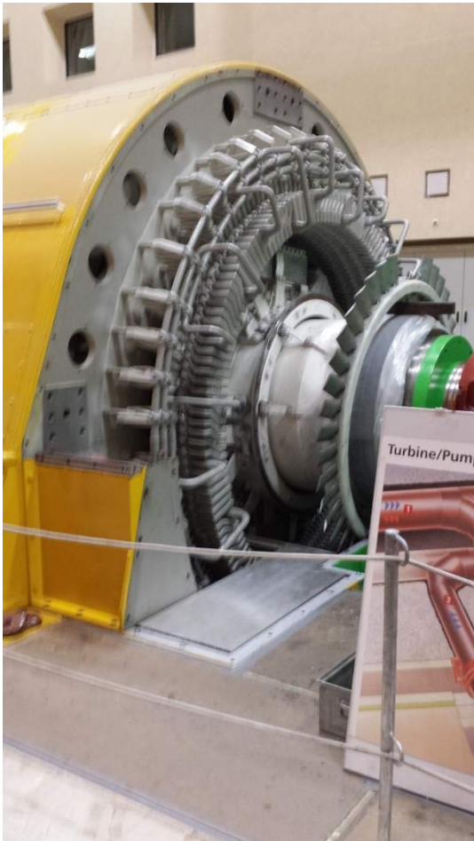
Jeder Generator wird durch eine Francis-Turbine angetrieben. Im Pumpbetrieb wird das zweite Francisrad benötigt. Im Vollbetrieb werden 80 Kubikmeter Wasser 400 Meter hinaufgepumpt. Der 100 MW-Umrichter ist als Baukasten aufgebaut, da er in Einzelteilen in die Kaverne gefahren wurde.
