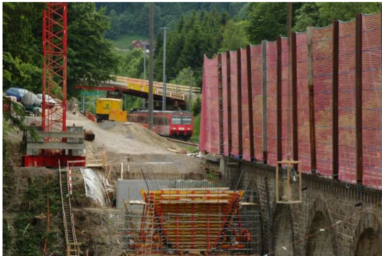
Besichtigung einer Brückenbaustelle der SOB (Foto M. Bosshard).
