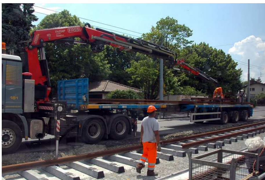
Rue de Chancy, déchargement des rails de tramway. La nouvelle ligne sera mise en service le 11 décembre (Foto Martin Bosshard).
