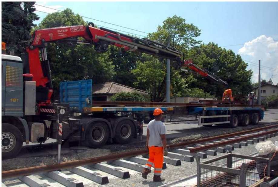
Ablad von Tramschienen in der Rue de Chancy. Die neue Linie 14 nach Bernex ging am 11. Dezember in Betrieb (Foto Martin Bosshard).
