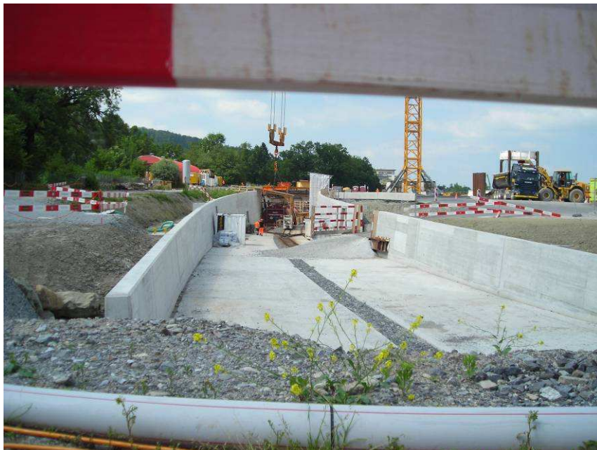
Rampe d'accès du nouveau tunnel Allmend (Photo M. Bossard).
