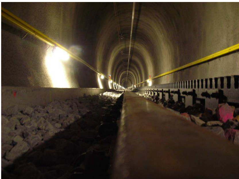
Le nouveau tunnel Engelberg en construction (Photo M. Bossard).
