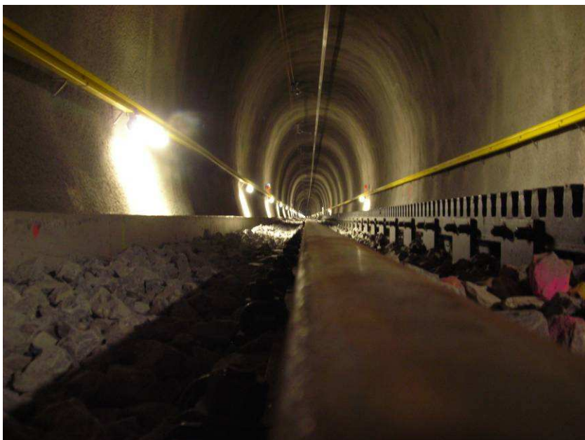
Der neue Tunnel Engelberg im Bau (Foto M. Bossard).
