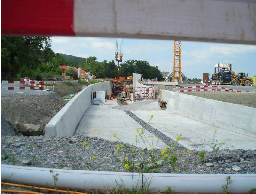
Rampe zum neuen Tunnel Allmend (Foto M. Bossard).
