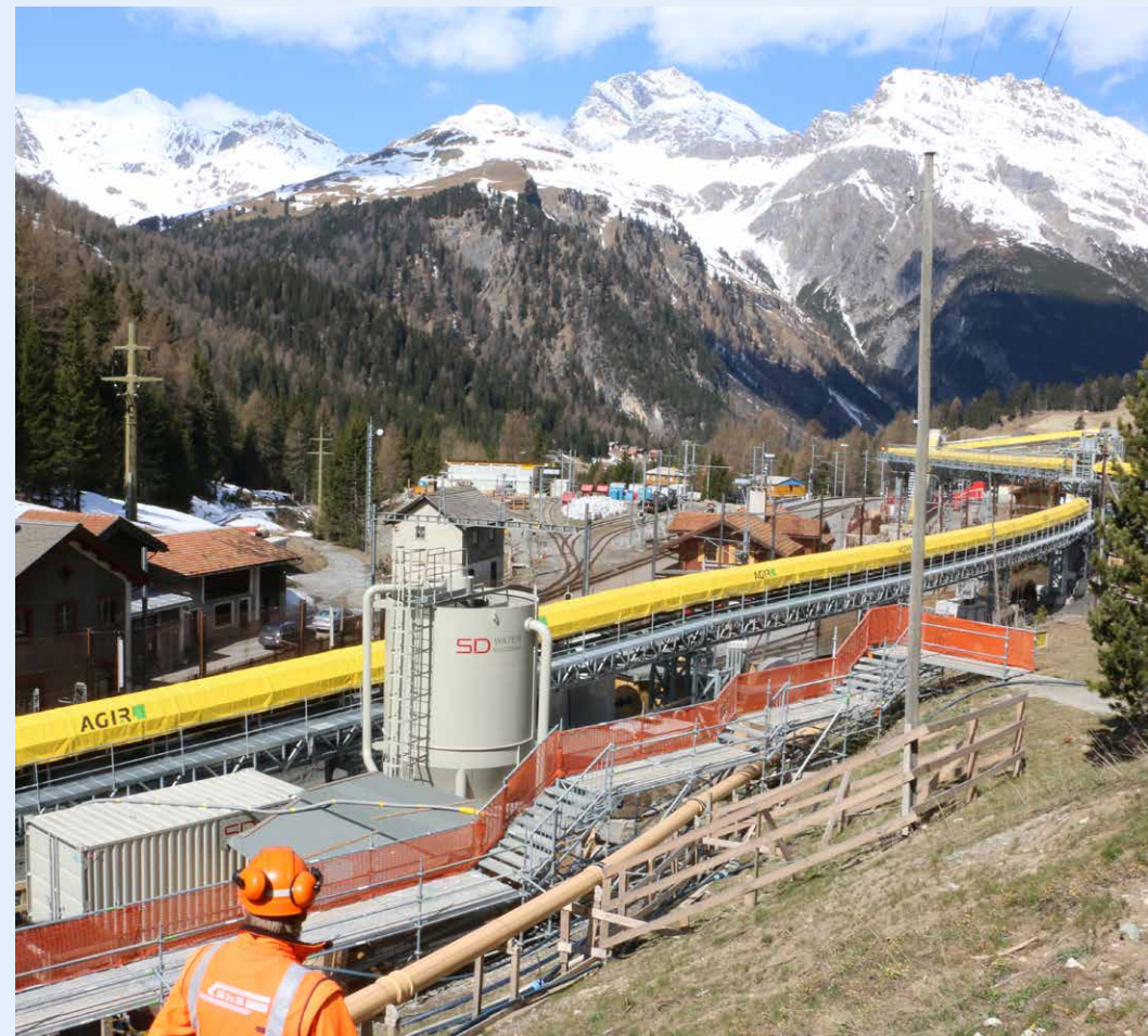
Fachtagung 2016 in Preda: Neubau des Albulatunnel. Colloque 2016 à Preda: nouveau tunnel de l'Albula.
