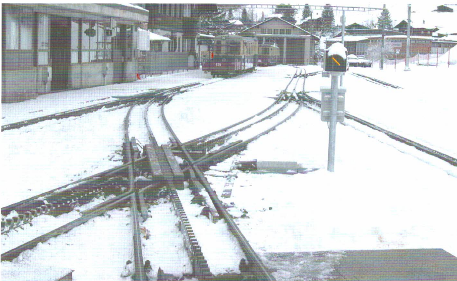
Bild 6: Kreuzung in Grindelwald Grund (Der drehbare Teil der Zahnstange ist an der speziellen Zahnstangenkonstruktion erkennbar. Da in den schweizerischen Fahrdienstvorschriften kein Signal zur Kennzeichnung des fahrtberechtigten Stranges einer Kreuzung mit Zahnstange existiert, wurde ein spezielles Signal kreiert.)
