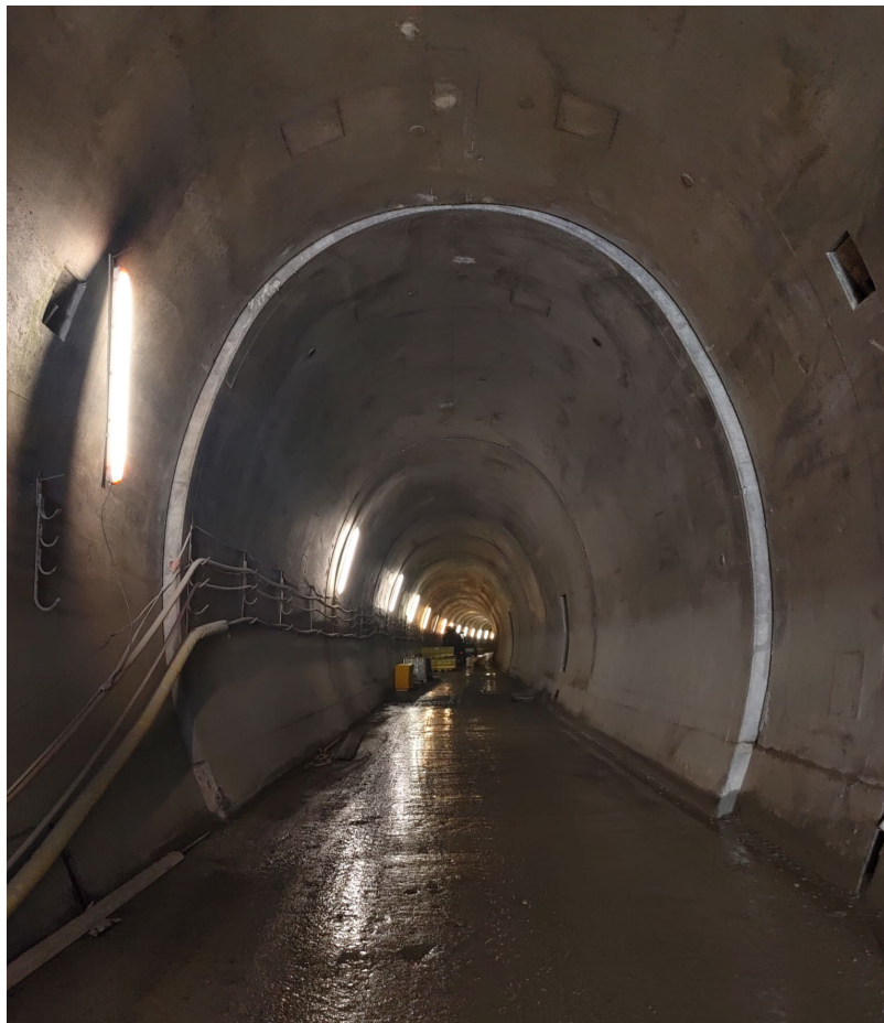
Das Infrastruktur Programm besichtigte den Albula Tunnel II, hier noch ohne Gleisanlagen
