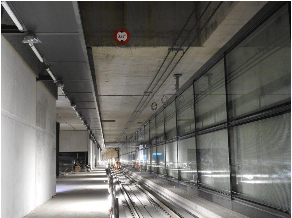
La gare CEVA des Eaux-Vives en cours d'équipement
