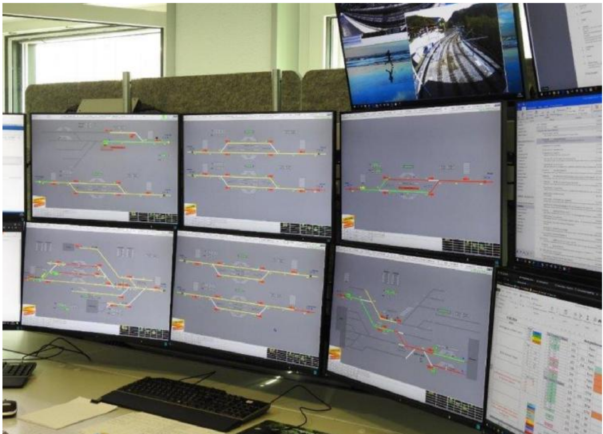
Centre de régulation à Wilderswil.
