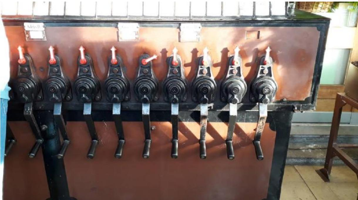
*Le vieil enclenchement mécanique de Chiètres qui est toujours fonctionnel.*
