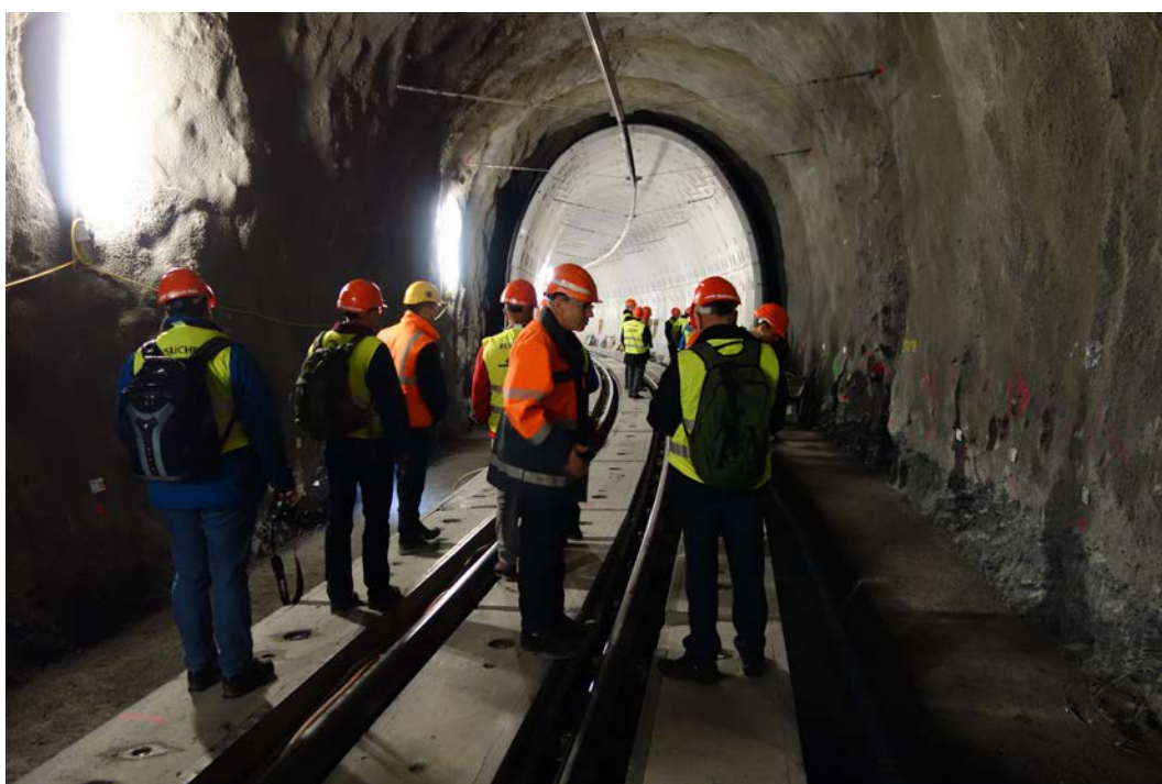
Remise à neuf de l'habillage du tunnel du Glatscheras par des éléments en béton préfabriqués (Photo: Martin Strobel).
