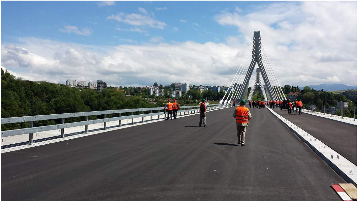
La chaussée bétonnée du pont de la Poya repose sur un tablier métallique continu. Les deux piliers du pont haubané sur les bords de la Sarine sont impressionnants.
