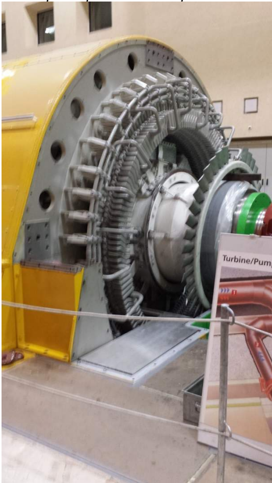
Chaque générateur est entraîné par une turbine Francis. La deuxième turbine Francis est utilisée en mode pompage. En plein régime, ce sont 80 mètres cube d'eau qui sont élevés de 400 m. Le convertisseur de 100 MW est modulaire, ce qui a permis de l'acheminer dans la caverne.
