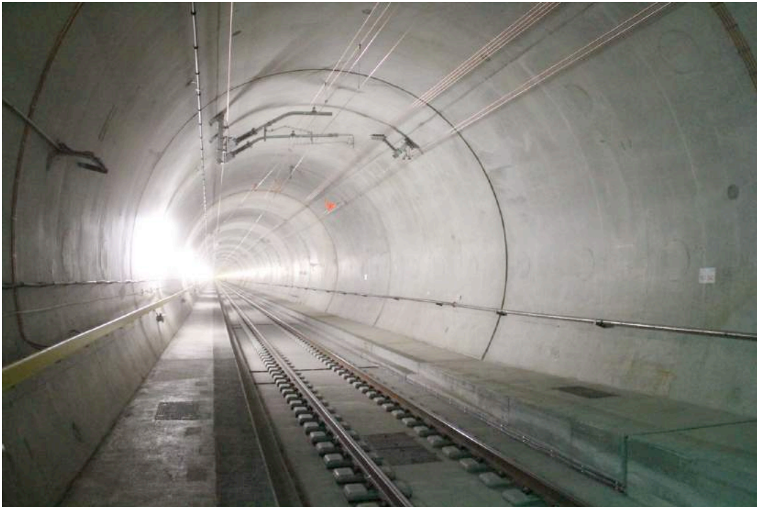
Vu d'un tube avec sa voie sans ballast et son installation de la caténaire terminée.
